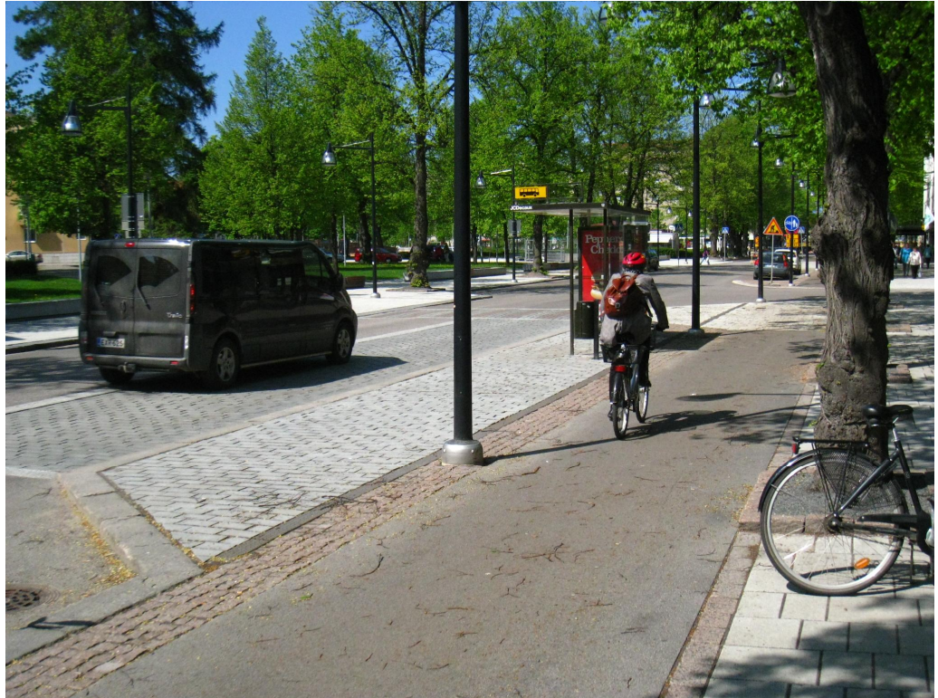
Kuva 3. Korkealuokkaista keskustarakentamista Rauman keskustan uudella puolella Valtakadulla: Laadukas ajoratapysäkki ja erillinen kevyen liikenteen väylä kestäväillä materiaaleilla ja riittäväällä mitoituksella.
