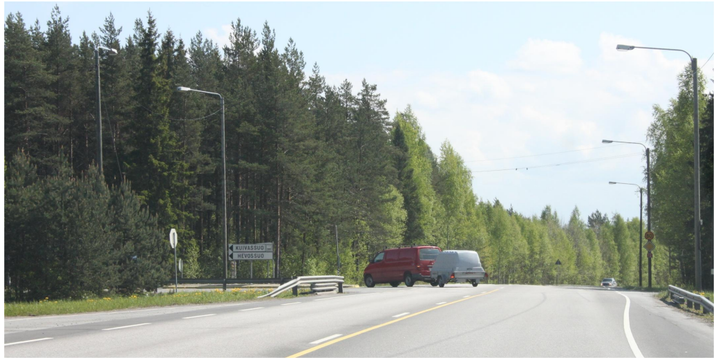
Kuva 6. Kuivassuontien teollisuusalueen liittymässä on väistötila ja sivusuunnalla tulppa. Vastaavanlaiset järjestelyt on lähempänä keskusta olevassa Koillisväylän liittymässä, jonka liikenteellinen merkitys on moninkertaistumassa.
