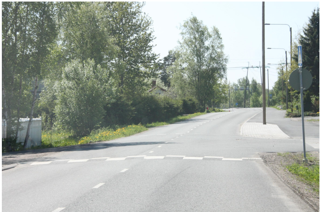
Kuva 20. Äyhöntiellä (yhdystie 12768) valtateiden 8 ja 12 välillä asuinalueen läpikulua on pyritty rajoittamana ja ajonopeuksia hillitsemään useilla hidasteilla.
