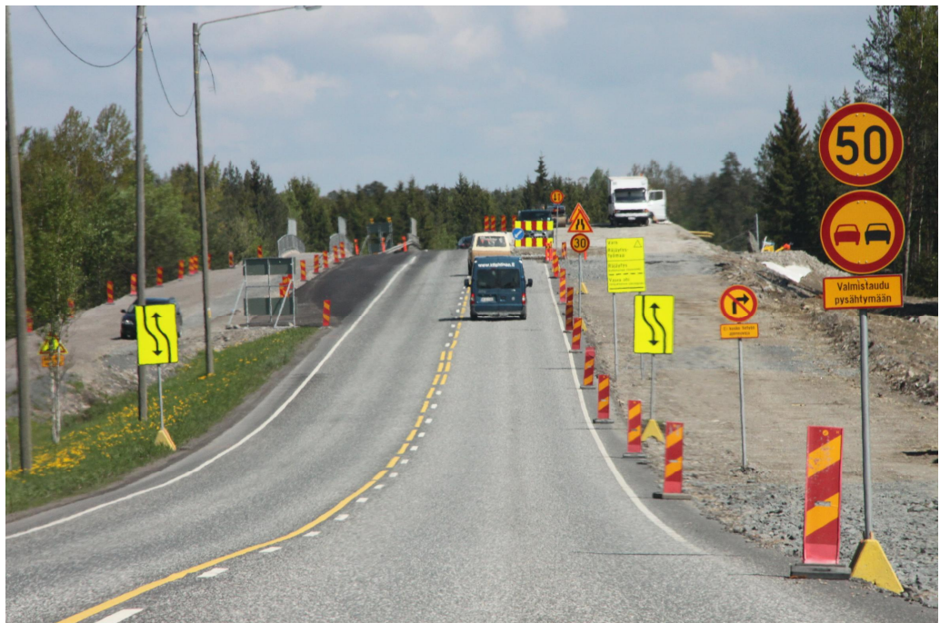
Kuva 19. Ohituskaistatiejaksoa rakennetaan valtatielle 8 Rauman keskustan pohjoispuolelle toukokuussa 2010.
